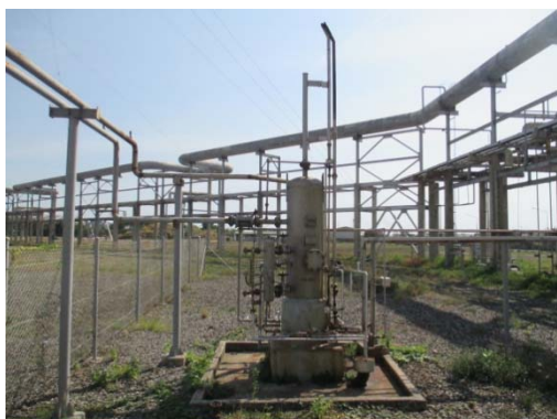
รูปที่ 3.1-2(2) ระบบกำจัดไอสาร ไฮโดรคาร์บอน (Vapor Disposal System)
