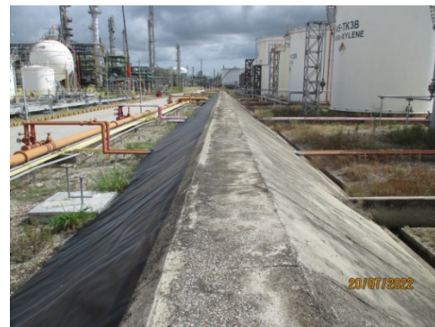
รูปที่ 3.1-2(57) คันกันล้นรอบ ถังเก็บสำรอง
