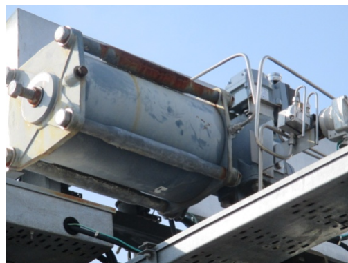
รูปที่ 3.1-2(84) Remote Shut-off Valve
