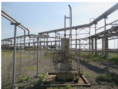
รูปที่ 3.1-2(6) ระบบกำจัดไอสาร ไฮโดรคาร์บอน (Vapor Disposal System) บริเวณลานถังเก็บกัก
