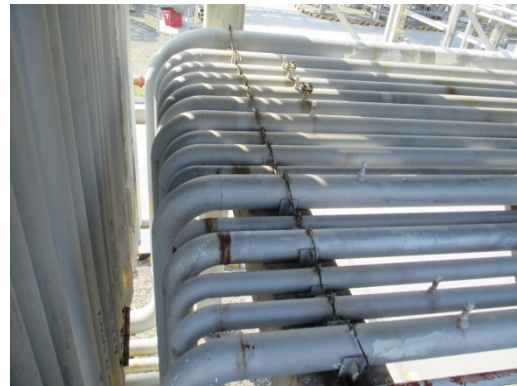
รูปที่ 3.1-2(82) สายดินบริเวณท่อขนส่ง
