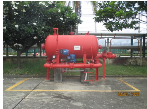
รูปที่ 3.1-2(67) ระบบโฟมดับเพลิง
