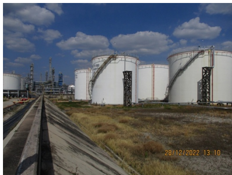
รูปที่ 3.1-2(5) ถังเก็บสำรองไฮโดรคาร์บอนชนิด IRFN และชนิด CRN
