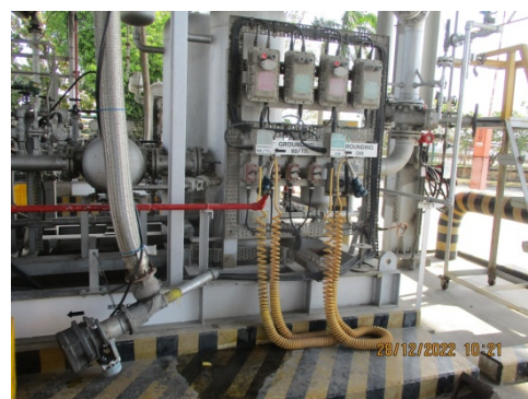
รูปที่ 3.1-2(65) Grounding บริเวณ Loading Rack
