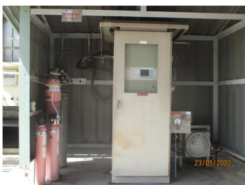
รูปที่ 3.1-2(4) อุปกรณ์การตรวจวัดการระบายมลสารจากปล่องอัตโนมัติ (CEMs)
