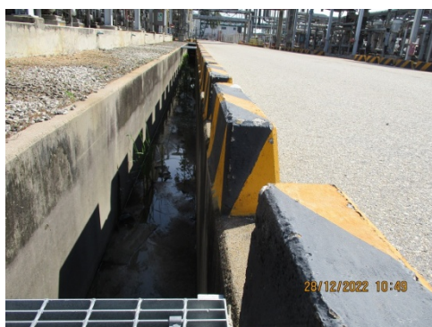
รูปที่ 3.1-2(32) Clean Water Sewer (CWS) บริเวณพื้นที่ลานถังเก็บกัก
