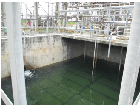
รูปที่ 3.1-2(28) ป่อ 940-XC1 ขนาด 280 ลบ.ม.
