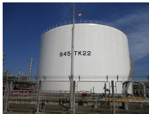
รูปที่ 3.1-2(69) ถังเก็บน้ำดับเพลิง
