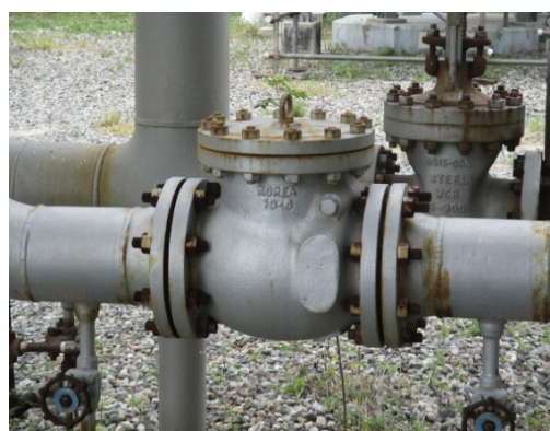
รูปที่ 3.1-2(87) Check Valve
