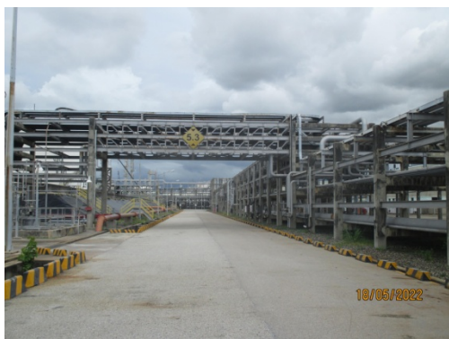
รูปที่ 3.1-2(80) ท่อรับส่งวัตถุดิบ-ผลิตภัณฑ์วางตัวบน Pipe Rack และ Pipe Bride
