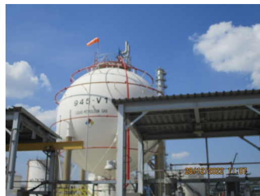
รูปที่ 3.1-2(79) ระบบฉีดพรมน้ำ บริเวณถังเก็บสำรอง
