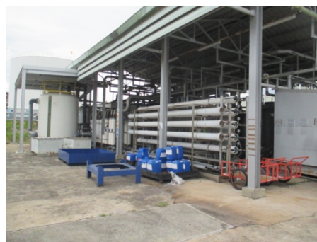
รูปที่ 3.1-2(27) ระบบ UF&RO
