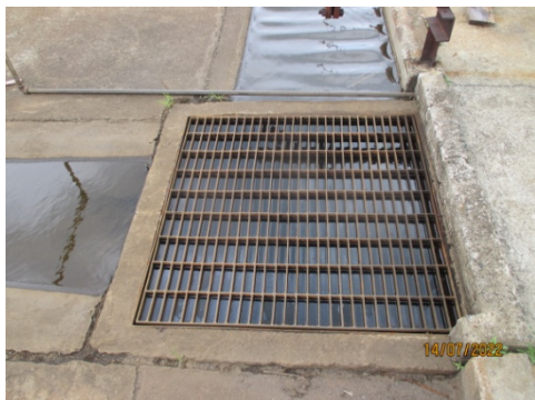
รูปที่ 3.1-2(10) Oily Water Sewer
