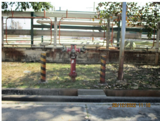
รูปที่ 3.1-2(70) Water Hydrant
