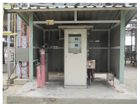
รูปที่ 3.1-2(4) อุปกรณ์การตรวจวัดการระบายมลสารจากปล่องอัตโนมัติ (CEMs)
