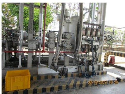
รูปที่ 3.1-2(64) Vapor Return Arm บริเวณ Loading Rack
