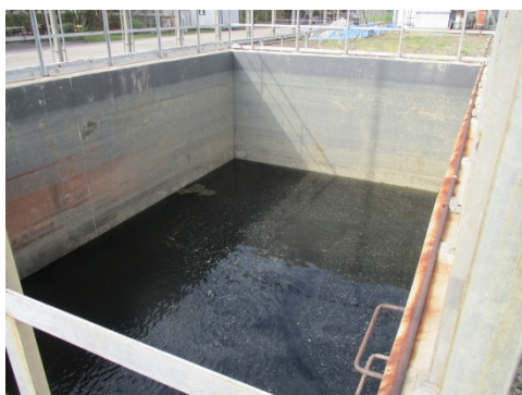
รูปที่ 3.1-2(30) Accidentally Oil Contaminated (AOC) บริเวณพื้นที่ลานถังเก็บกัก
