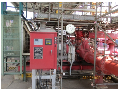
รูปที่ 3.1-2(73) ปั๊มน้ำดับเพลิง แบบ Diesel Pump
