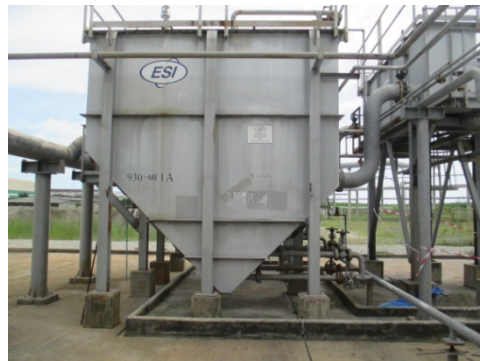
รูปที่ 3.1-2(15) CPI Separator
