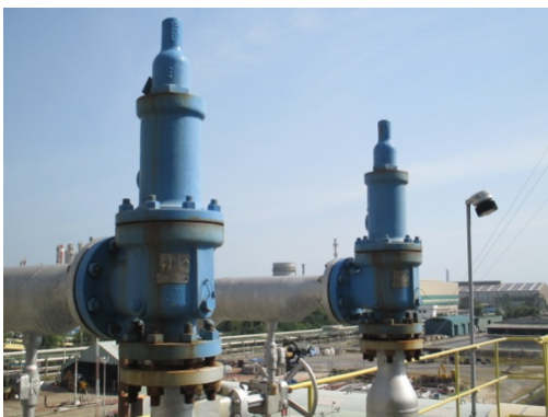
รูปที่ 3.1-2(83) Safety Valve บนท่อขนส่ง
