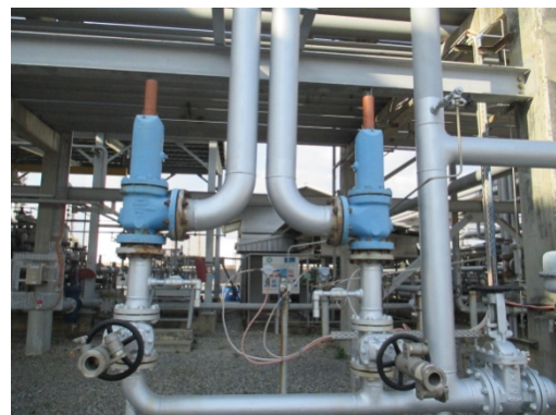
รูปที่ 3.1-2(83) Safety Valve บนท่อขนส่ง
