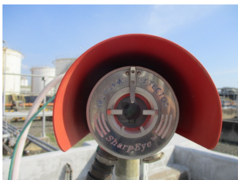
รูปที่ 3.1-2(62) Flame Detector
