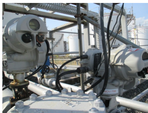
รูปที่ 3.1-2(85) On-Off Valve
