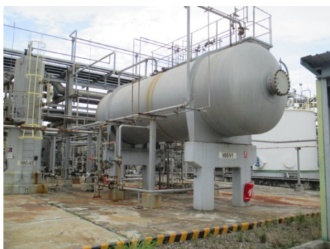
รูปที่ 3.1-2(16) ระบบ Neutralization Drum (980-V1)
