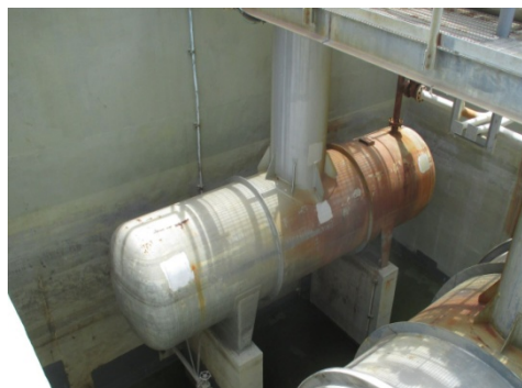
รูปที่ 3.1-2(29) Closed Aromatics Drain (CAD) บริเวณพื้นที่ลานถังเก็บกัก
