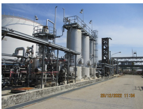
รูปที่ 3.1-2(8) Vapor Recovery Unit
