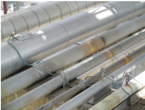
รูปที่ 3.1-2(82) สายดินบริเวณท่อขนส่ง
