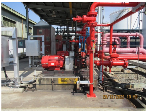
รูปที่ 3.1-2(78) ปั้มน้ำดับเพลิงแบบไฟฟ้า
