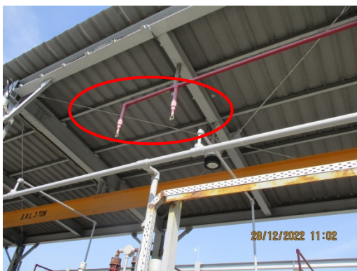
รูปที่ 3.1-2(76) ระบบ Sprinkler
